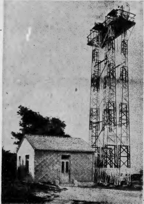
FIG. 2. — ASPECT DE L'INSTALLATION DE LA PREMIÈRE LIAISON COMMERCIALE SUR ONDES CENTIMÉTRIQUES LYMPNE-SAINT-INGLEVERT EN 1934 (17 CM DE LONGUEUR D'ONDE)
